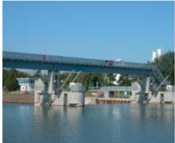
Le barrage de Creil (Copyright VNF)
